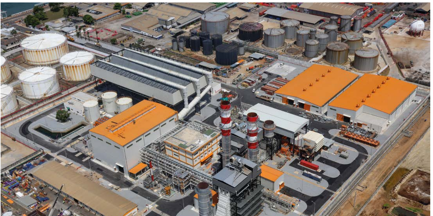
Centrale thermique CIPREL
