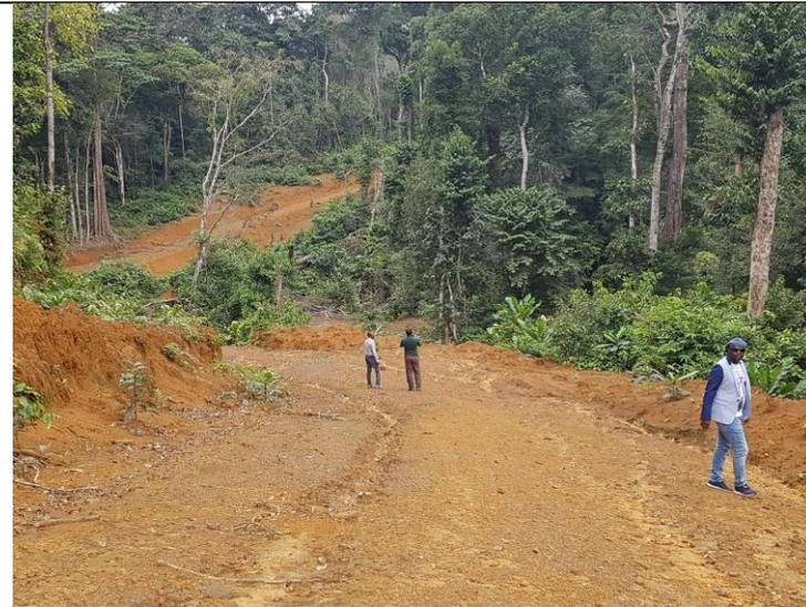
3.8 Route d'accès au barrage en rive droite du Komo, avec, en arrière-plan la route d'accès sur la rive gauche (construites par la SEEF sous contrat de prestation).
