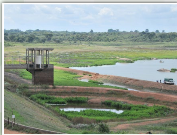
Barrage de la Loka à Bouaké (mars 2017)
